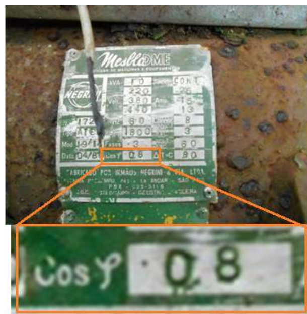
Figura 3 – Etiqueta informativa de um dos geradores da Faz. Itatinga e detalhe do Fator de Potência.
