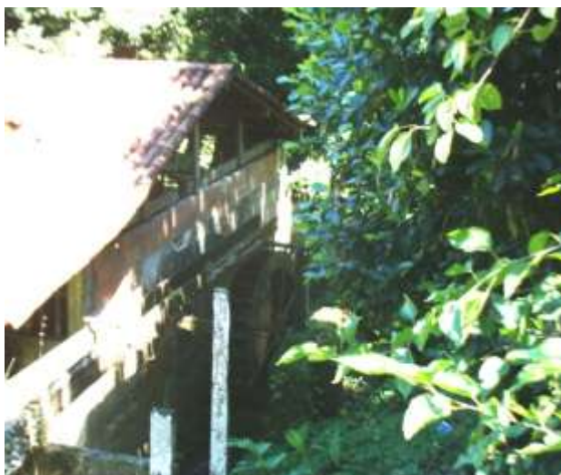
Figura 5 – Roda D'água do alambique da Cachaçaria Corisco, Bairro do Corisco em Paraty.
